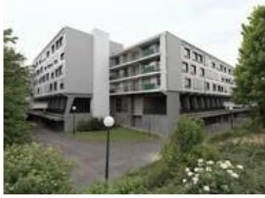
Les barres E et F. La structuration verticale du bâtiment est organisée à partir de box fermé sur une rue située contrebas de l'immeuble, d'un rez-de-chaussée sur pilotis accédant à des parking en rez-de -chaussée par des passerelles, d'une élévation de trois ou quatre étages selon les immeubles.
