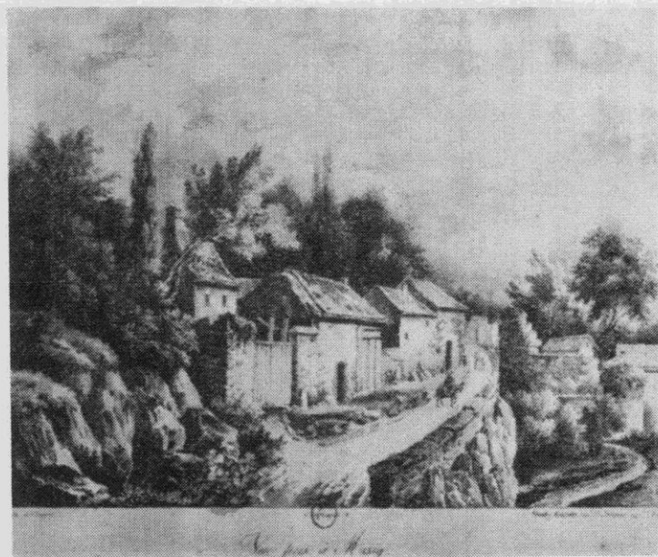
FIG. 9. — ROUTE DE VILLAINES A MASSY VERS 1830. Derrière les masures qui bordent la route à gauche, le vieux château (Biblioth. Nat. Estampes).
