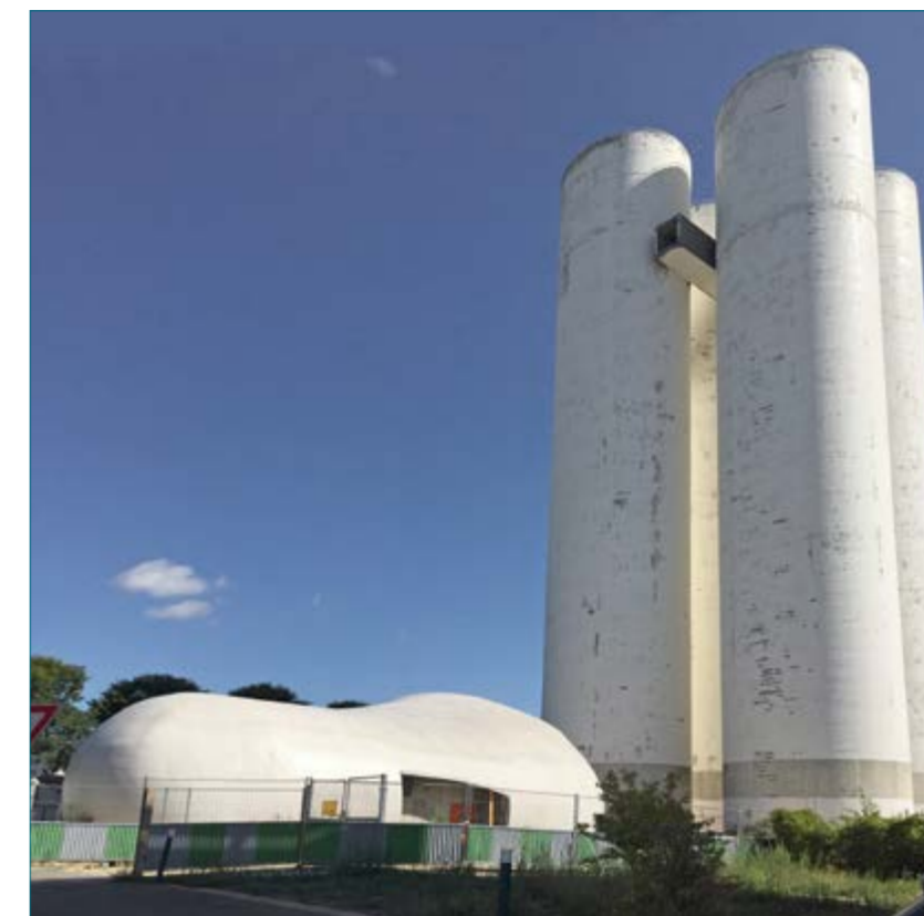
L'ancien château d'eau et la nouvelle station de pompage le 28 août 2018
